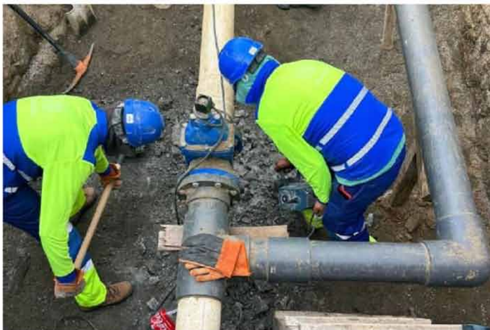
Aqualia ha completado la sustitución de medidores de agua y tomas domiciliarias en uno de los principales destinos turísticos de México
