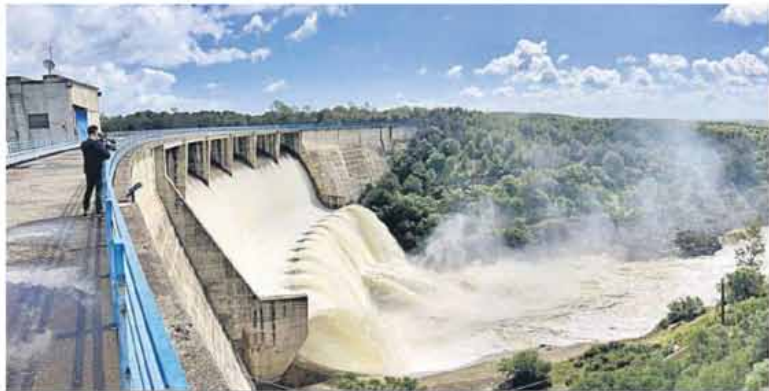
Abril 2024. El Gergal aliviando miles de litros de agua tras las lluvias.
