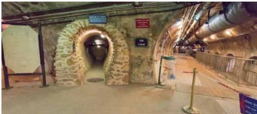
Museo del alcantarillado
