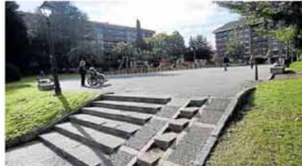
Los accesos con peldaños en Llamaquique.
