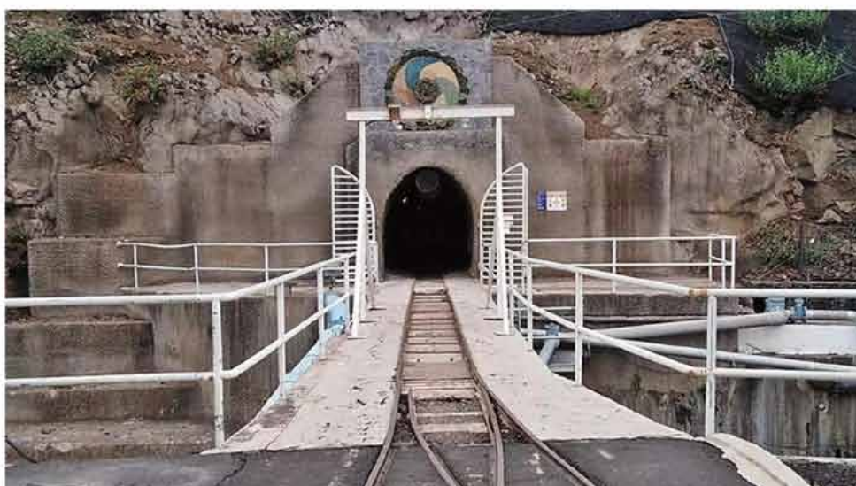
Imagen de una de las entradas del Túnel de Trasvase.
