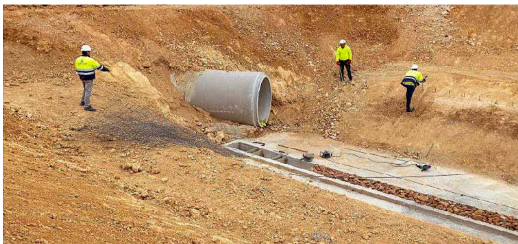
La construcción del tanque de tormentas en las obras de urbanización del polígono Sepes. / TOMÁS FERNÁNDEZ DE MOYA
