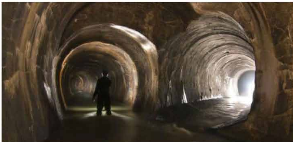
Interior del alcantarillado en Madrid
