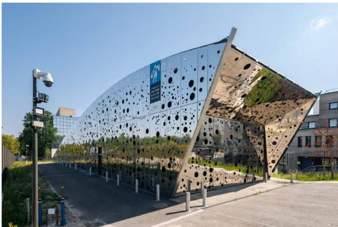
La station de pompage a été construite à deux pas de l'ancienne. (©Nicolas Fagot/SEDIF)
